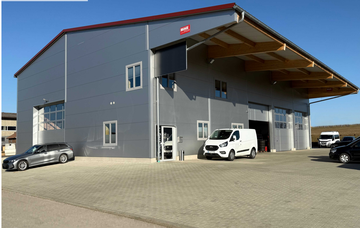
Werkstatt mit Lager und Büroräume Energieeffizient mit Wärmepumpe und Betonkernaktivierung
